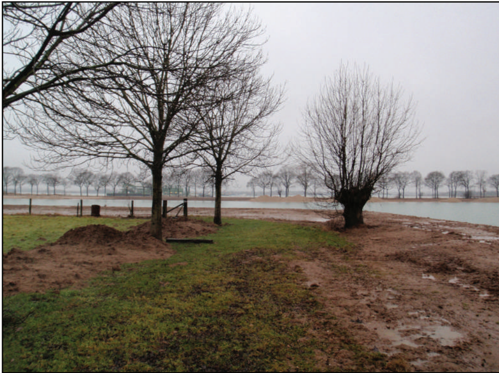
Afbeelding 17: De oevers van de ontgraving in de oostelijke plas worden afgewerkt. Op de achtergrond is de Steegstraat te zien.
