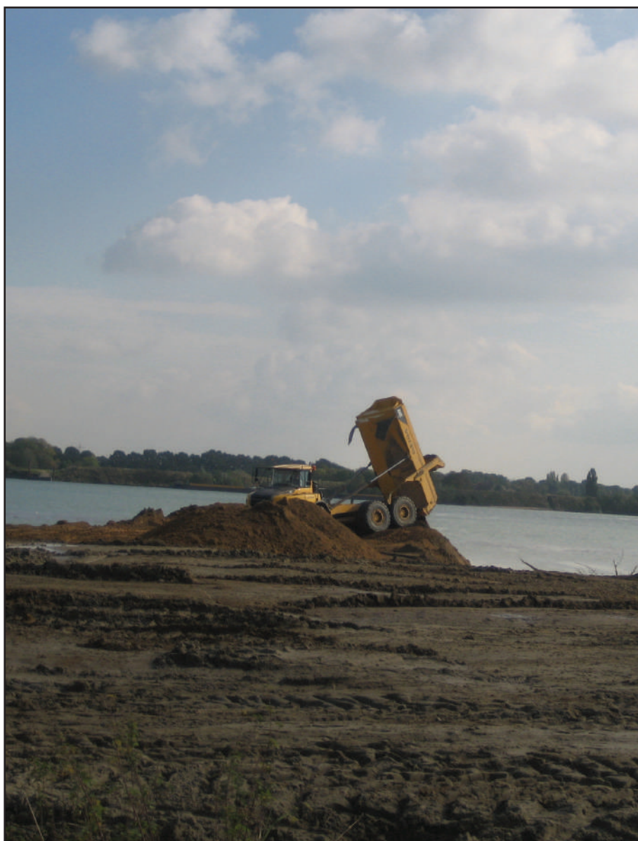
Afbeelding 7: De ontgrondingswerkzaamheden door Smals
