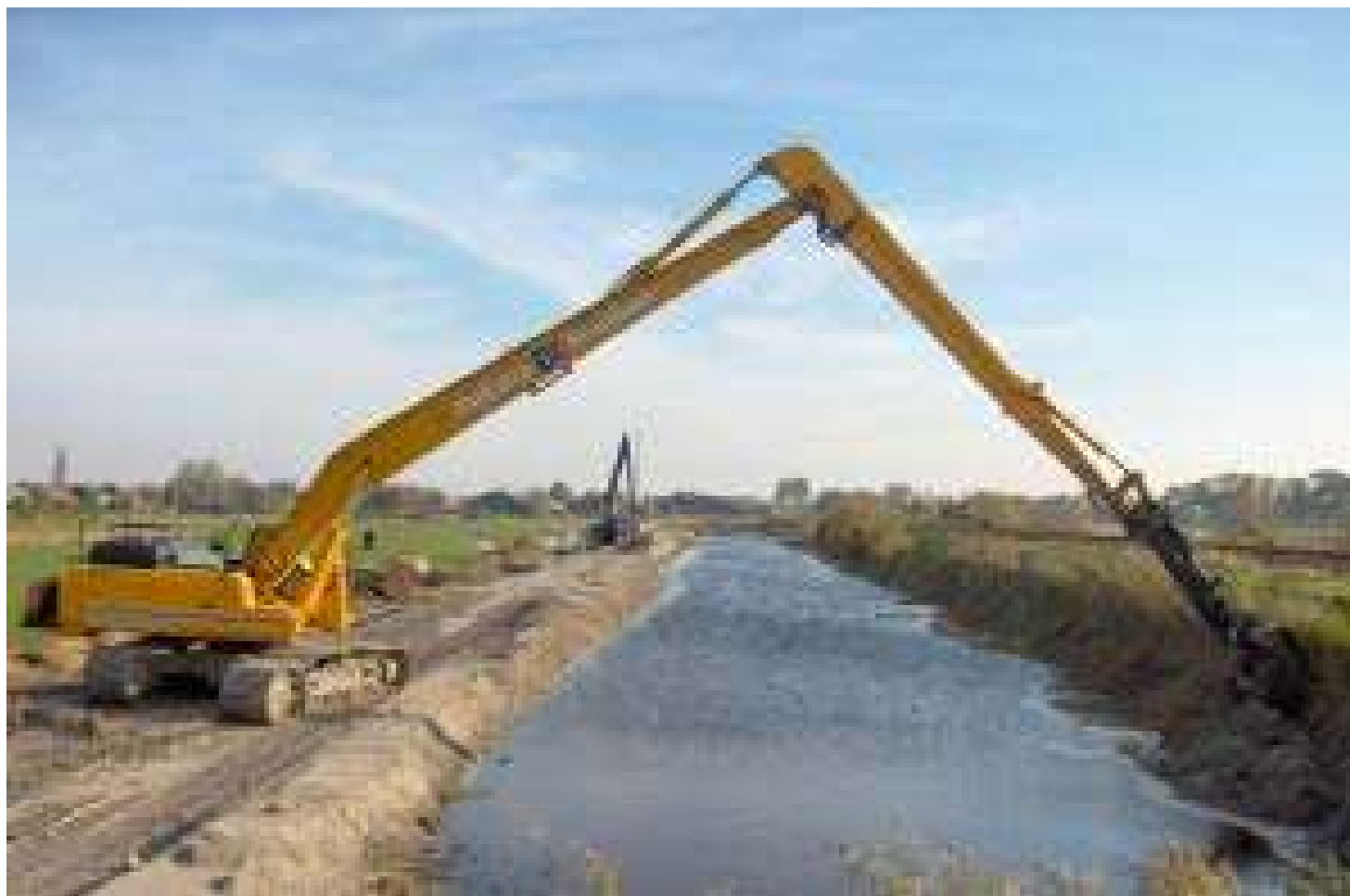
figuur 13: Rupskraan met verlengde giek, bron: roelofhuizingcultuurtechniek.nl/Baggerwerk
